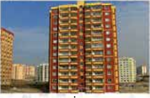
Demir Glass İnşaat
