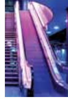
Yürüyen Yollar Moving Walkways
